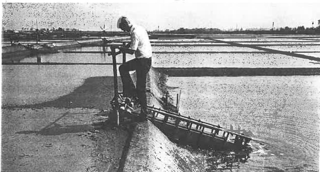
**Fig. 2-19** - Pompe à eau chinoise, en bois, utilisée pour faire monter l'eau dans des marais salants
